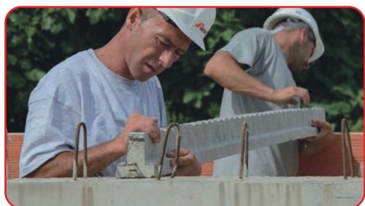
Poser les poutrelles.
