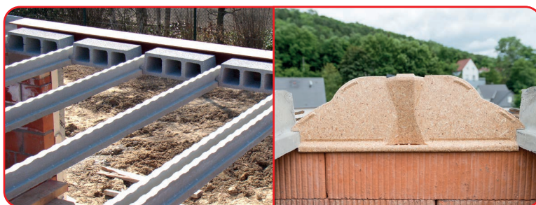
Fixer l'entraxe des poutrelles en posant un entrevous (ou un obturateur ou un rupteur thermique) en intercalaire.
