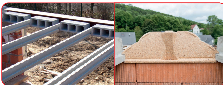
De tussenafstand van de balkjes bepalen door het plaatsen van een vulsteen, een eindstuk of een thermische onderbreker op de uiteinden hiervan.
