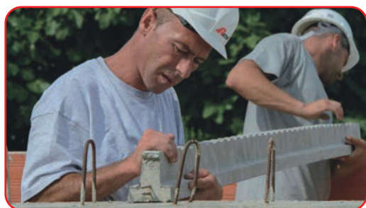
De balkjes plaatsen.
